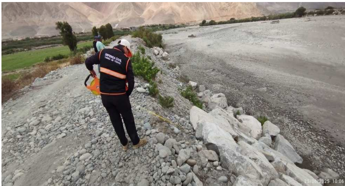
FIGURA N°02: TRAMO CRITICO 02, INICIO DE TRAMO CRITICO, PERDIDA DE PROTECCION DE ENROCADO
